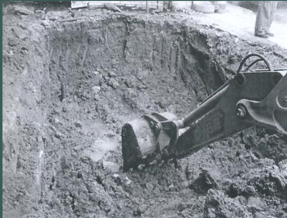
Foto 3 – Escavação para remoção do solo
