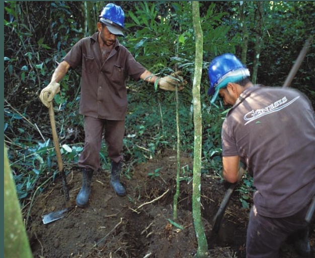
Retirada das árvores com torrão
